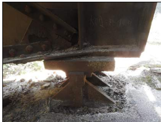
foto č. 6: K 02 P. HL. N. ložisko na P 01 - prosedlé ložisko foto č. 7: K 02 P. HL. N. ložisko na P 02 - prosedlé, zkřížené
