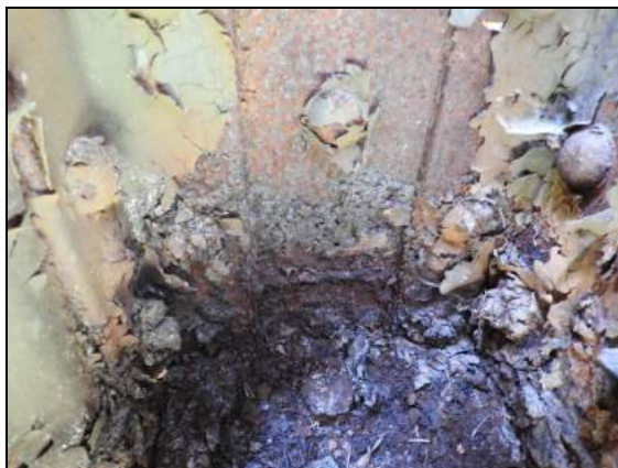
foto č. 1: K 01 L. HL. N. nad ložiskem O 01 - korozní oslab. foto č. 2: K 01 1. PŘ. ztužení - oslabení, strávené nýty
