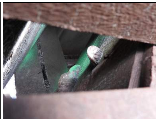
foto č. 23: K 01 mostnice č. 3 vlevo - dřevokazné houby
