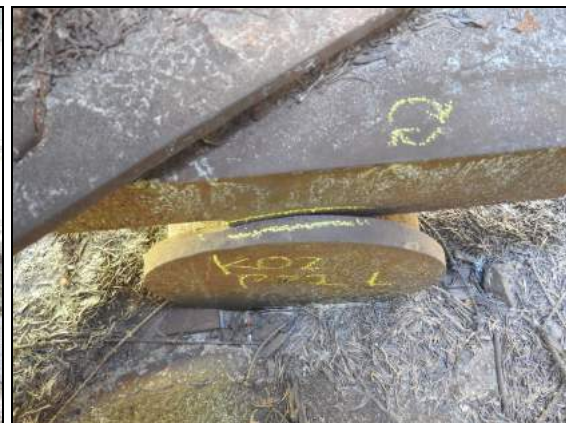
foto č. 6: K 02 P. HL. N. ložisko na P 01 - prosedlé ložisko foto č. 7: K 02 P. HL. N. ložisko na P 02 - prosedlé, zkřížené
