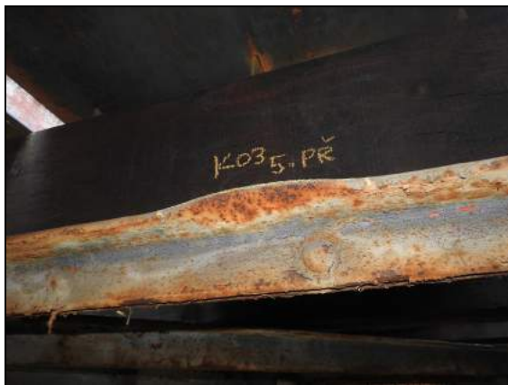
foto č. 12: K 03 5. PŘ. ztužení - deformace úhelníku
