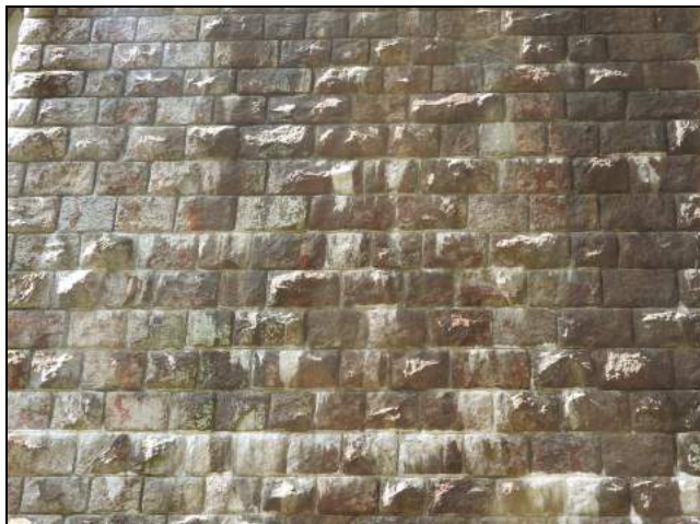
foto č. 18: P 01 z 2. otvoru - průsaky vody s výluhy pojiva
