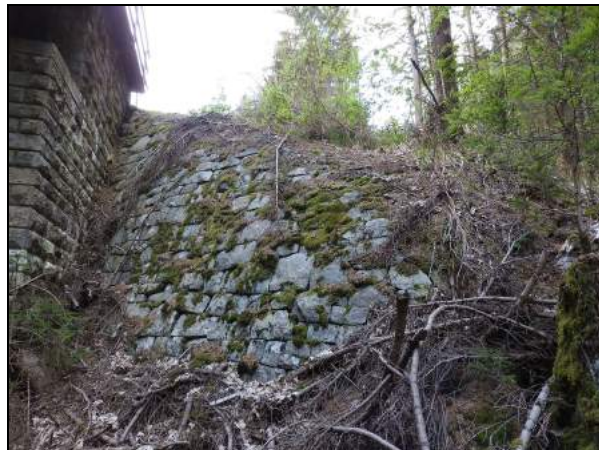
foto č. 21: O 02 svahový kužel vpravo - rozvolněné kameny
