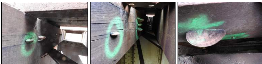
foto č. 25: K 03 most. č. 32 - houba foto č. 26: K 03 most. č. 38 - houba foto č. 27: K 03 most. č. 40 - houba
