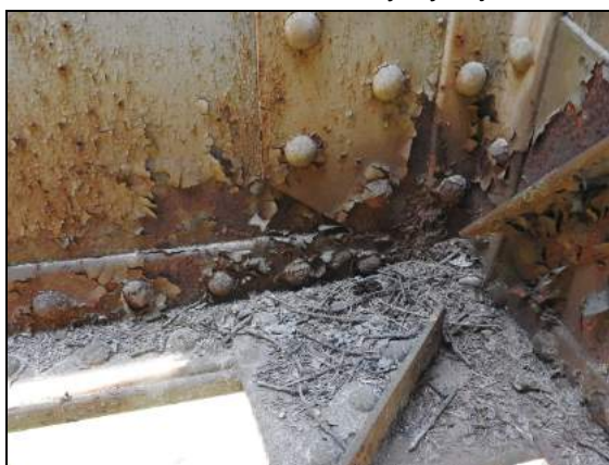
foto č. 8: K 03 L. HL. N. styč. plech u 8. PŘ. ztuž - koroze
