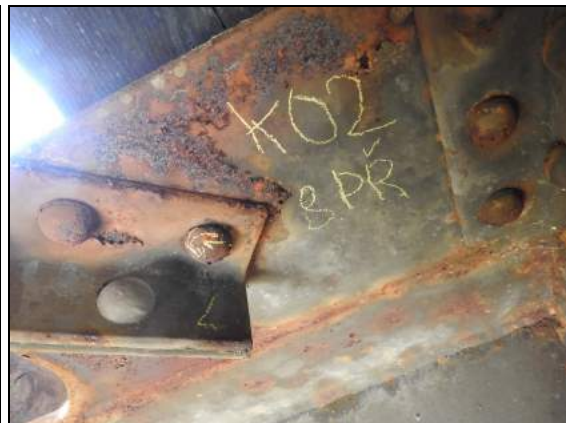
foto č. 4: K 02 L. HL. N. nad ložiskem P 01 - korozní oslab. foto č. 5: K 02 8. PŘ. ztužení - volný nýt
