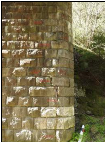
foto č. 15: O 01 vlevo - svislá trhlina
