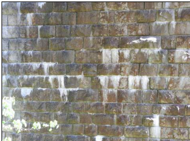
foto č. 17: P 01 z 1. otvoru - průsaky vody s výluhy pojiva
