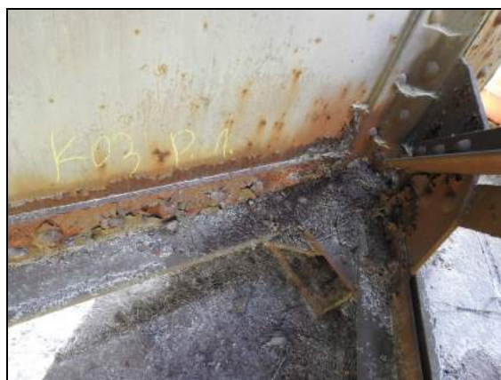
foto č. 9: K 03 P. HL. N. 1. pole styč. plech - korozní oslabení
