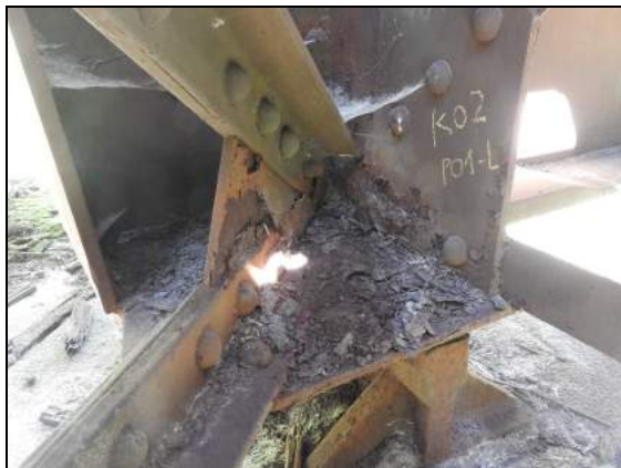
foto č. 4: K 02 L. HL. N. nad ložiskem P 01 - korozní oslab. foto č. 5: K 02 8. PŘ. ztužení - volný nýt
