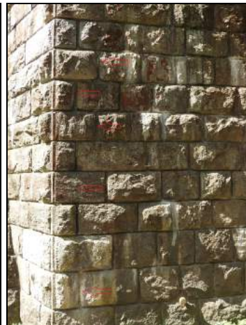
foto č. 16: O 01 vpravo - svislá trhlina
