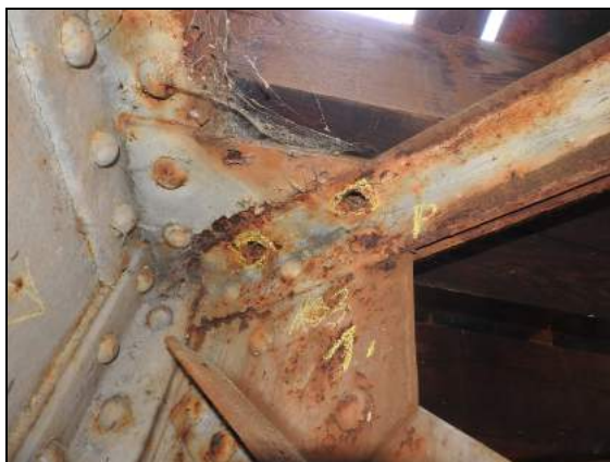
foto č. 10: K 03 1. PŘ. ztužení styč. plech - chybějící nýty
