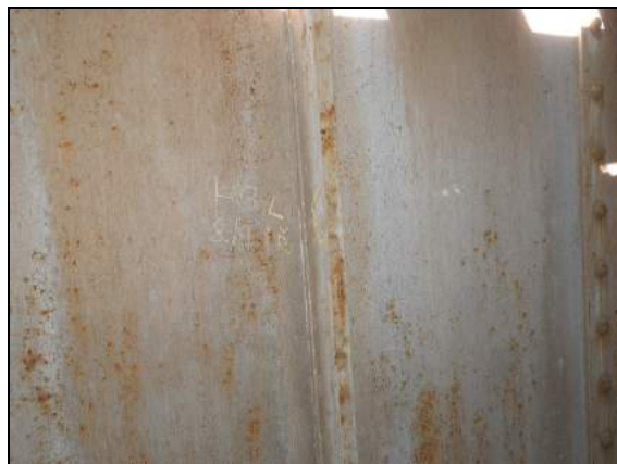
foto č. 13: K 03 L. HL. N. mezi 8. 9 PŘ. ztužení - deformace
