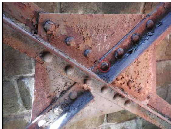
foto č. 1: K 01 L. HL. N. nad ložiskem O 01 - korozní oslab. foto č. 2: K 01 1. PŘ. ztužení - oslabení, strávené nýty
