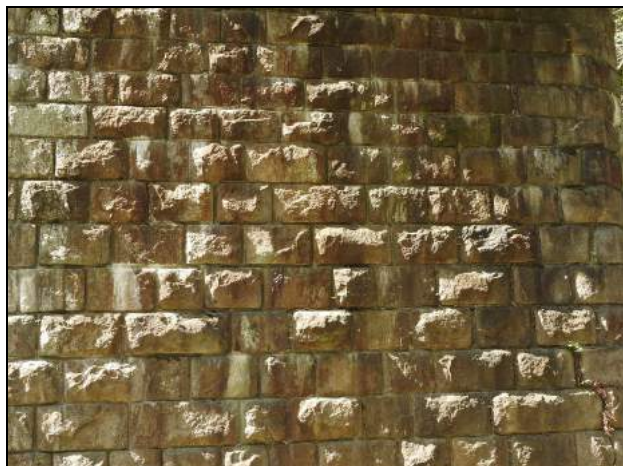
foto č. 14: O 01 střed - průsaky vody s výluhy pojiva
